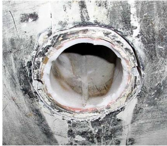
Das neue Loch für das Lager ist ausgesägt worden.
