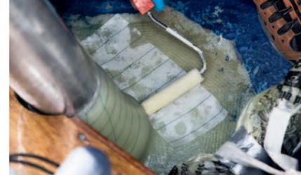
**9** **AUFGEHAUPT** Zum Schluss wird eine Lage Abreißgewebe aufgebracht. Dieses Nylonmaterial nimmt das überschüssige Harz auf. Nach dem Aushärten wird es wieder abgezogen, und die Oberfläche kann ohne langwieriges Schleifen mit Topcoat überstrichen werden
