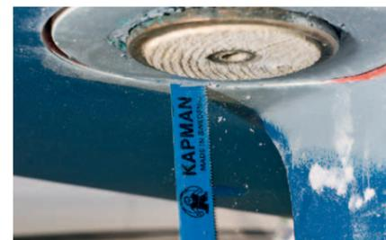
**6** **GESÄGT** Da nicht nur durch den Rumpf, sondern auch durch das Anlaminat des alten Kokers gebohrt werden muss, kann die maximale Eintauchtiefe der Bohrkronen nicht ausreichend sein, um den Koker vollständig abzutrennen. Dann hilft ein Eisensägeblatt
