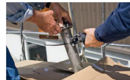
**7** **GETEILT** Weder das dickere untere Ende noch der angeschweißte Kopfbeschlag passen durch das Loch im Deck, deshalb muss der Koker zersägt werden. Mit einer kräftigen Säbelsäge oder einer Flex ist das in wenigen Sekunden erledigt
