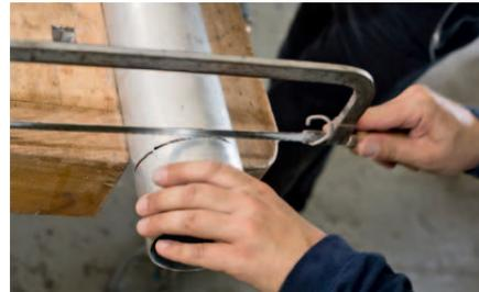
**1** **ABGELÄNGT** Da das obere Lager direkt im Deck sitzt, muss der Koker nicht mehr bis ganz nach oben reichen. Sein Abschluss sollte aber mindestens zehn Zentimeter über der Wasserlinie liegen, besser mehr. Nach dem Ablängen außen mit 60er-Papier aufrauen und sorgfältig entfetten
