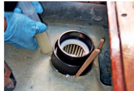
**3** **EINSPRITZEN** Nun kann das Lager fest mit dem Rumpf verbunden werden. Dazu füllt man den Spalt mit eingedicktem Epoxid-Harz, das anschließend komplett durchhärten sollte. Die endgültige Festigkeit erhält die Konstruktion später beim Einlaminierten des Kokerrohrs
