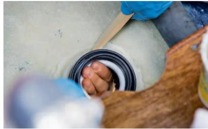
**2** **ABGERUNDET** Zur besseren Krafteinleitung wird am Übergang zwischen Lager und Rumpf eine Hohlkehle aufgespachtelt. Der Radius sollte mindestens drei bis fünf Zentimeter betragen. Je dünner das Laminat des Rumpfes ist, desto größer muss der Radius der Hohlkehle ausfallen
